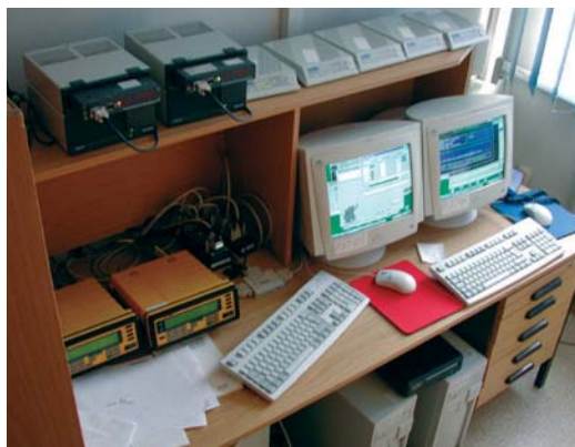
Abb. 2: Innenansicht einer Referenzstation
