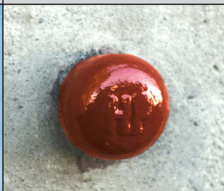
HFP Mauerbolzen (Ø 2 cm bis 5,5 cm) oder Höhenmarke
