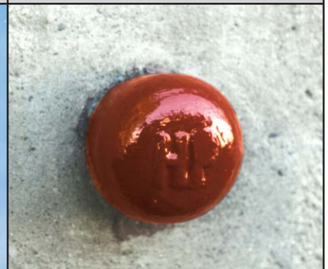
HFP Mauerbolzen (Ø 2 cm bis 5,5 cm) oder Höhenmarke
